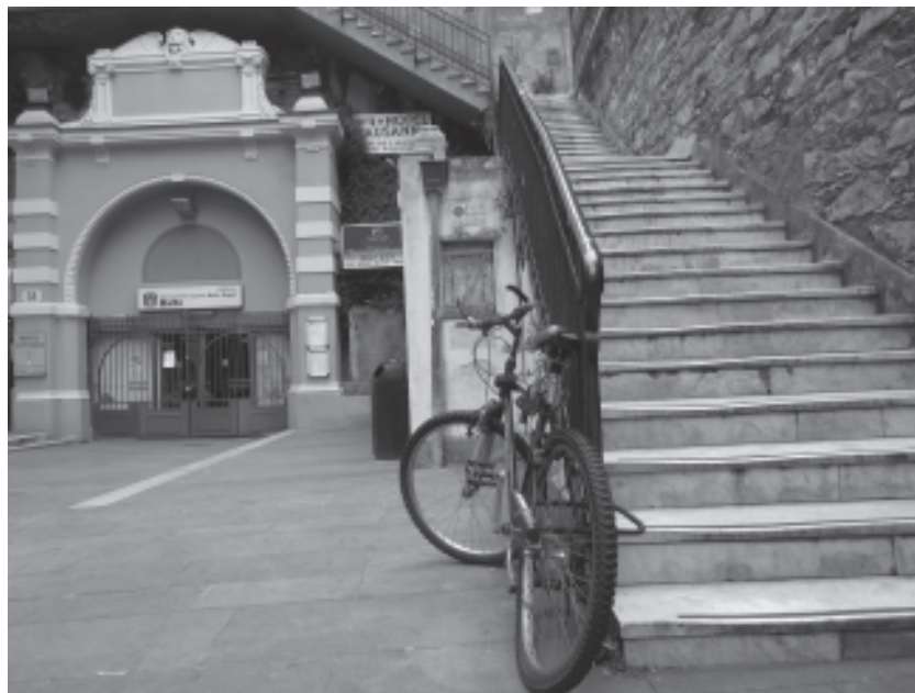
La partenza dell'ascensore di Montegalletto (c.a.)
