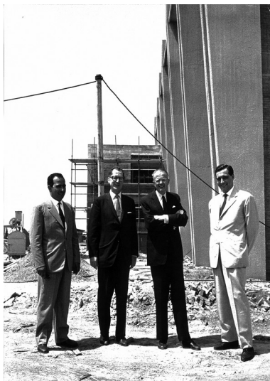
(da sinistra) Ennio Melis, Giuseppe Ornato e due dirigenti americani davanti al cantiere della Palazzina Studi in costruzione
