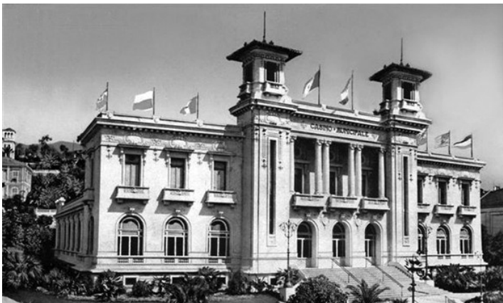
Il Casinò di Sanremo appena costruito, nel 1905
